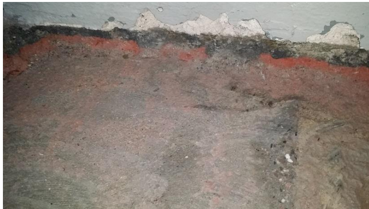
Abb.3: asbesthaltiger Steinholzstrich
