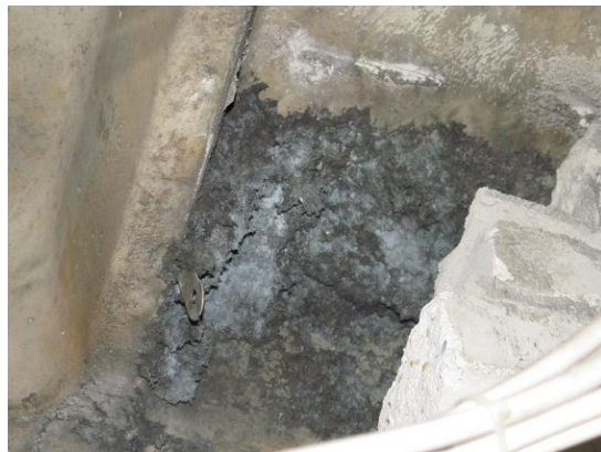
Abb.2: Spritzasbest
