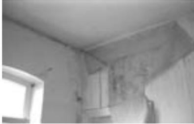
**ABB. 17:** Schimmelpilzbefall auf und unter der Tapete. Deutlich zu sehen der schmale, von Schimmelpilzen befallene Streifen entlang der geometrischen Wärmebrücke zwischen Zimmerdecke und Außenwand.
